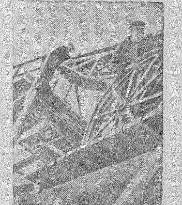
НА СНИМКЕ: Монтаж металлоконструкций на строительстве бетонного завода Керченского железнорудного комбината.
