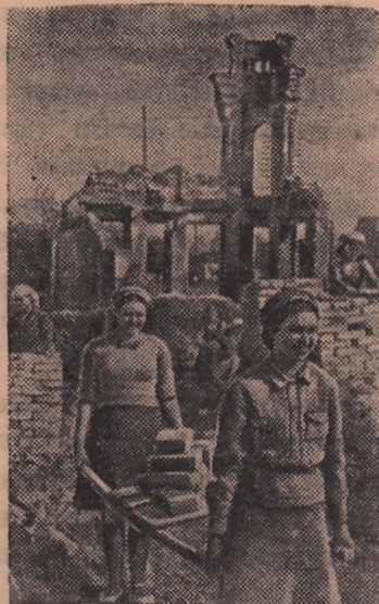
На снимке рабочие 5-го строительного участка Северо-Кавказской железной дороги на восстановительных работах. Впереди стахановки — комсомолки З. С. Кивва (слева) и Р. А. Иаченко.
