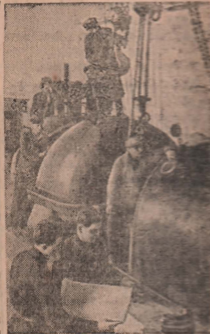
Завлачивается восстановление турбогенератора мощностью 6 тысяч киловатт на второй электростанции города Минска (Белоруссия).
