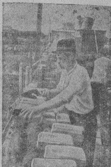
Лауреат Сталинской премии, орденосеца С. С. Максименко недавно продемонстрировал на строительстве малоэтажных домов в Щемилровке (Ленинград) разработанный им поточно-конвейерный метод кладки кирпича. За 7 рабочих часов бригада Максименко уложила 42 тысячи кирпичей, выполнив 10,5 нормы. На снимке: лауреат Сталинской премии С. С. Максименко на стройке. Фото А. Перовщикова. Прессклише ТАСС
