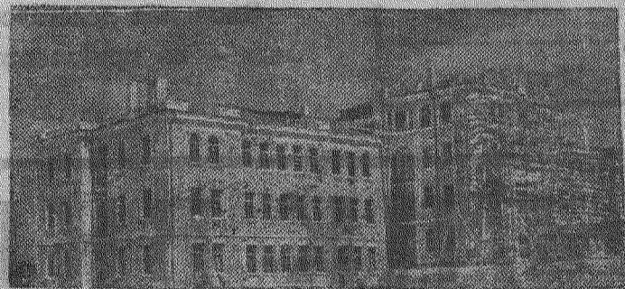
Заканчивается восстановление главного корпуса Мияского политехникума, разрушенного гитлеровскими захватчиками.
