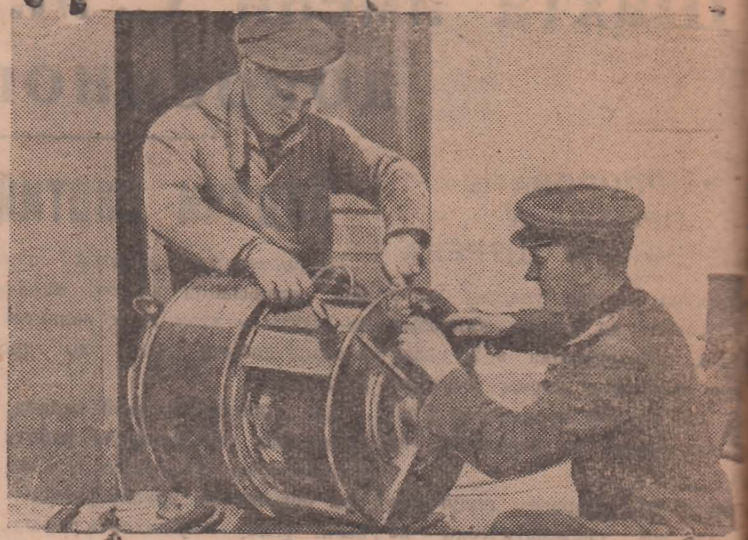
Моряки одного из подразделений Черноморского флота готовят подарок своему подшефному колхозу им. Чкалова генератор сельской электростанции.
