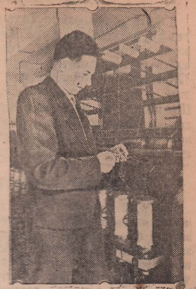
Инженер Ленинградского текстильного института имени С. М. Бирова М. В. Башкирову присуждена Сталинская премия за разработку оригинальной конструкции узлового узла для устранения обрывов нитей, широко внедренного в текстильную промышленность. На снимке: инженер М. В. Башкиров ликвидирует обрыв нити на круглых ватерах с помощью изобретенного им узлового узла. Фото А. Михайлова.
