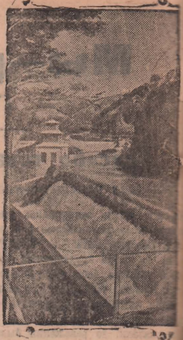
В Армянской ССР орошается около 200 тысяч гектаров земель больше, чем до революции. Длина оросительной системы превышает 10 000 километров. Одна из самых крупных сооружений республики является канал имени Сталина. Его протяженность — километра, сросшаемая им площадь равна 22 тысячам гектаров. На снимке: боковой вид на канал имени Сталина. Фото В. Егоров
