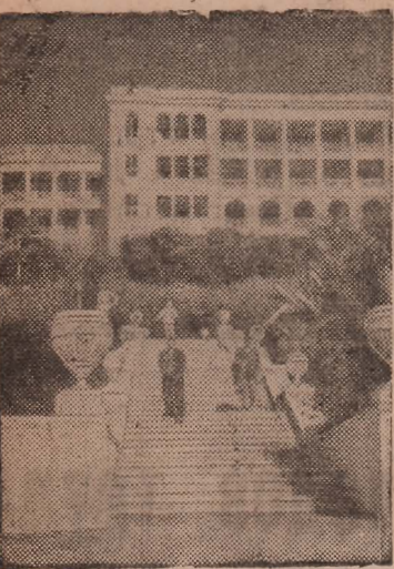
Сочи. Санаторий ВЦСПС № 1. Спальный корпус. Фото Д. Мелешкина Прессклише ТАСС
