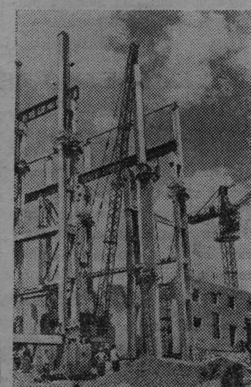
В Сталинграде строится алюминиевый завод — один из крупнейших в стране. Цехи его возводятся из сборного крупнопанельного железобетона. Уже сданы в эксплуатацию цехи металлоконструкций, паровозное депо и ряд других подсобных помещений, построено около 50 километров железнодорожных подъездных путей.
