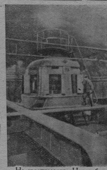
На строительстве Новосибирской ГЭС сдан в эксплуатацию третий агрегат. Монтируются следующие турбины и генераторы.
