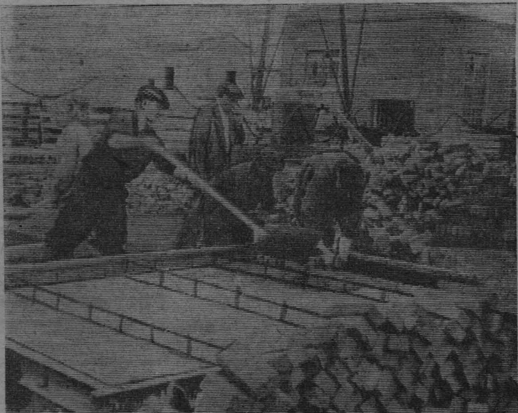
В форму укладывается кирпич.
