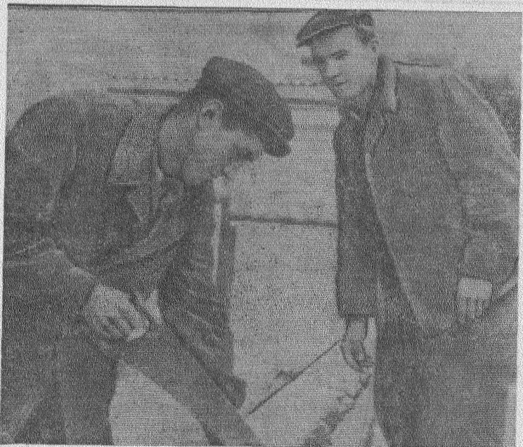
Строительство жилья — первоочередная задача. Это хорошо помнят плотники стройгруппы углеразведчиков. Бригада Петра Ивановича Кияева прилагает все силы для того, чтобы в срок сдать дома, и люди могли бы жить в благоустроенных квартирах.
