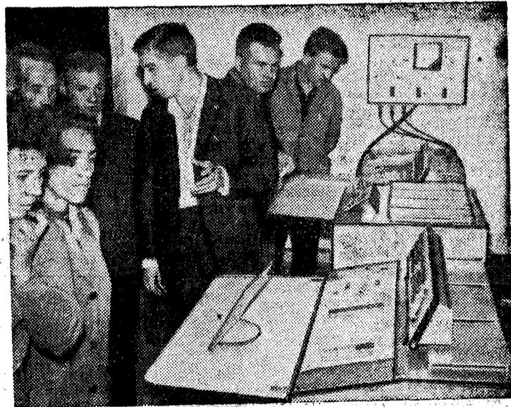
Электронная цифровая управляющая машина «Днепр» на полупроводниковых элементах, которую вы видите на этом снимке, прислана на Выставку достижений народного хозяйства СССР Киевским совнархозом. Она предназначена для контроля и управления производственными объектами и процессами в различных отраслях промышленности и может быть использована также в качестве универсальной вычислительной машины.
