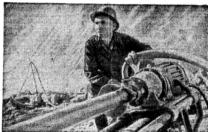
В Пулисангинском ущелье на горной реке Вахш сооружается крупнейшая в Таджикистане Нурекская ГЭС. Строительство ее ведется в трудных горных условиях. Широко применяются здесь буровые и взрывные работы.
