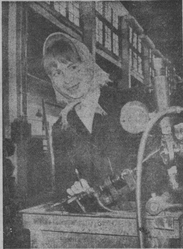
Пройдет немного времени, и эта девушка получит специальность техника-технолога. А сейчас комсомолка Тanya Сметанова работает в цехе № 25 завода «Кузбассэлемент». Она испытывает аккумуляторы на герметичность.
