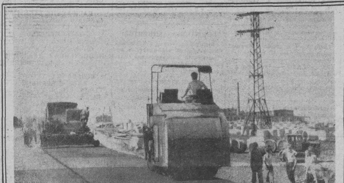
Сооружение дороги к строящемуся комбинату костюмных тканей. Фото В. Скоробогатова.
