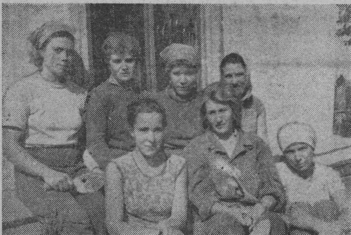
Недаром у девушек из бригады Г. Скороделовой хорошее настроение. Они вовремя закончили ремонт ШРМ № 9 шахты «Полысаевская-2».
