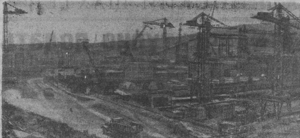
Дивногорск. На строительстве Красноярской ГЭС. Правобережный котлован, где сооружается здание будущего гиганта гидроэнергетики. Фото Ю. Бармина.
