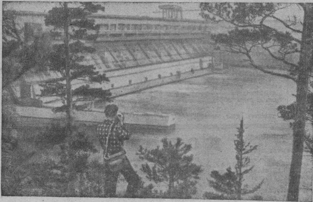
Вид крупнейшей в мире Братской ГЭС.
