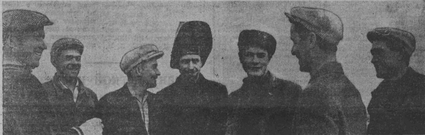
Звено Сергея Серегина — передовое в Ленинском строительном управлении треста «Кузбассжилстрой». Сейчас лучшие люди этого звена помогают осваивать монтаж крупнопанельных домов в сельской местности.
