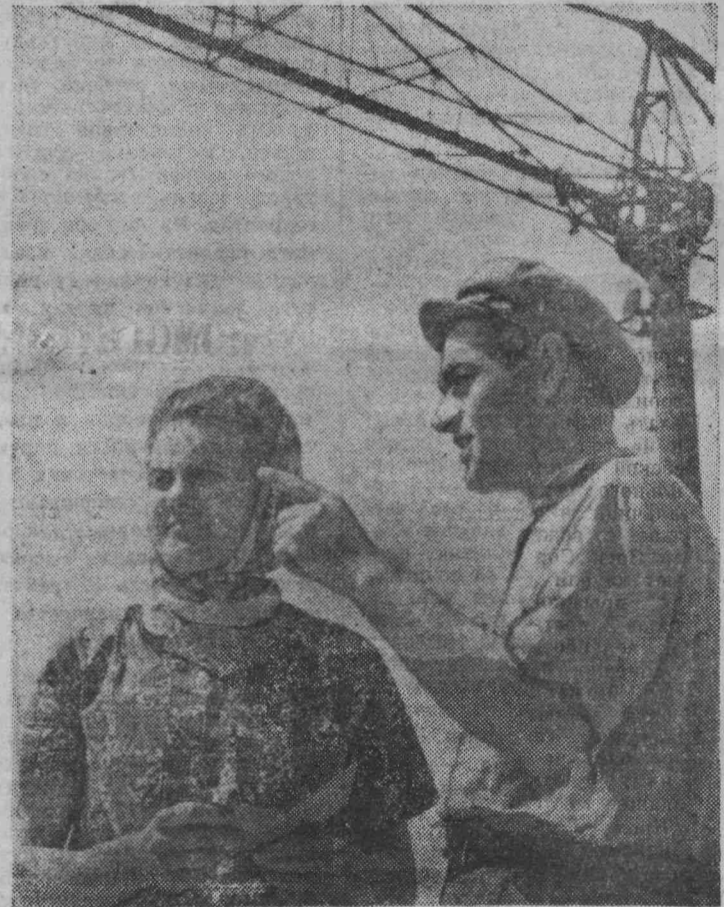
Отлично трудятся накануне выборов в Верховный Совет СССР машинист башенного крана Наталья Кошкарлова и монтажник Александр Недосекин. На строительстве холодильника они пользуются заслуженным авторитетом. Фото С. Викторова.
