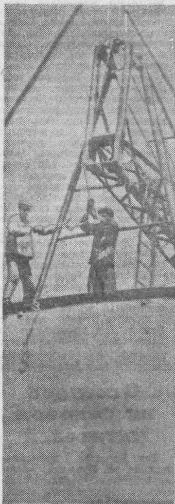
Идет сооружение нового газогольдера емкостью 3 тысячи кубометров.
