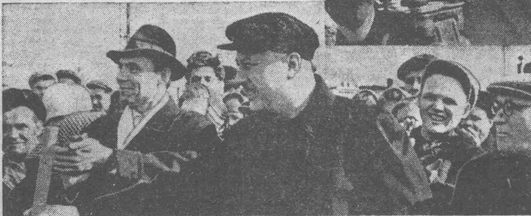
На верхнем снимке: маркшейдер В. А. Дыбунов дает отметку на первый фундамент. Внизу: директор строящегося комбината костюмных тканей В. Д. Алферов передает лопату строителям. Текст А. Ладутько. Фото В. Языченко.
