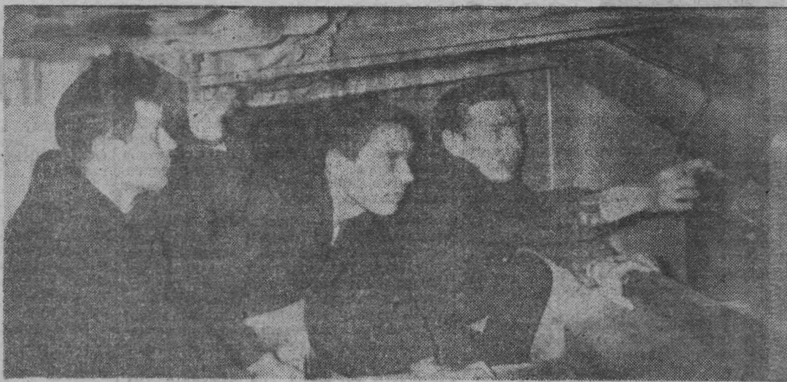
На шахте имени С. М. Кирова усиленно идет техническое перевооружение очистных забоев. В лавах внедряются угледобывающие комплексы с механической передвижной крепью. Поэтому организовано массовое обучение рабочих для лав, оборудованных гидрофицированными агрегатами. На снимке секции гидрофицированной крепи, установленные в учебном пункте. С ними знакомятся горнорабочий М. И. Рыльцев, зарядчик ВШТ Н. А. Бадардинов, ремонтник путей И. Д. Антипин. Фото А. Вострикова.
