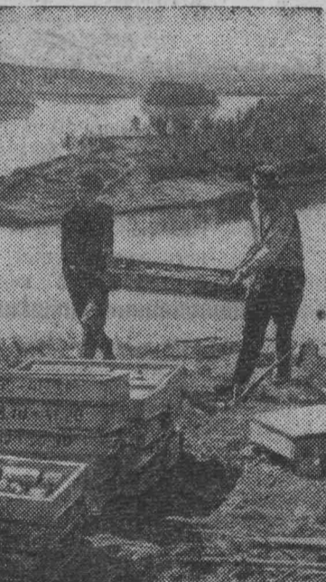
Толстый мыс на Ангаре. На вершине его бурильщики бурят пробы скальной породы. Толстый мыс подставит свое плечо плотине Усть-Илимской ГЭС — третьей гидроэлектростанции Ангарского каскада. К юбилею Октября строители спешат завершить подготовку котлована первой очереди для гидроэлектростанции.
