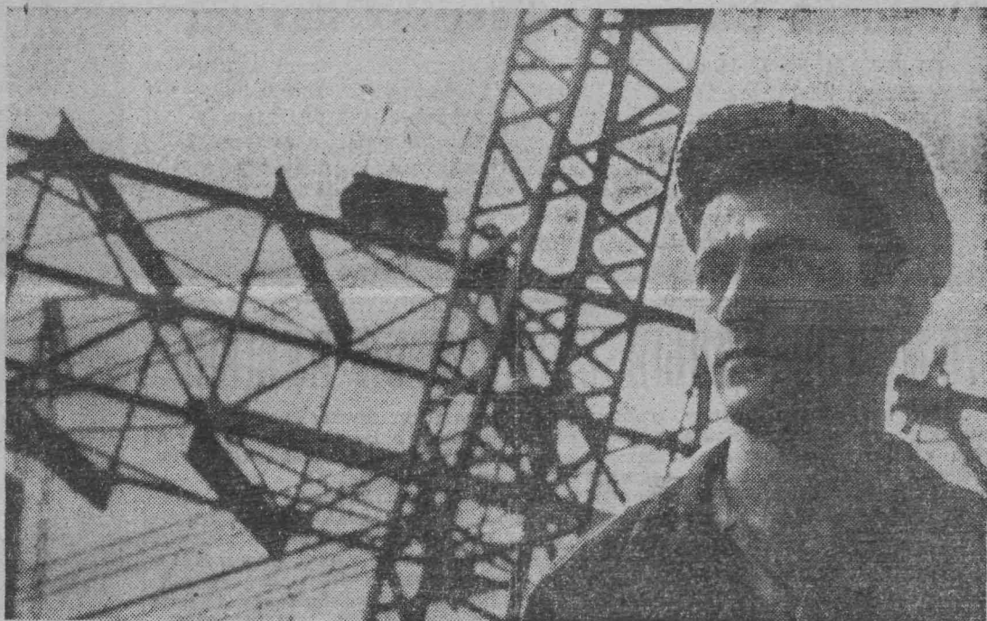
Замечательно трудится на строительстве скипового ствола шахты имени С. М. Кирова звено Виктора Федоровича Цитнера. За-
