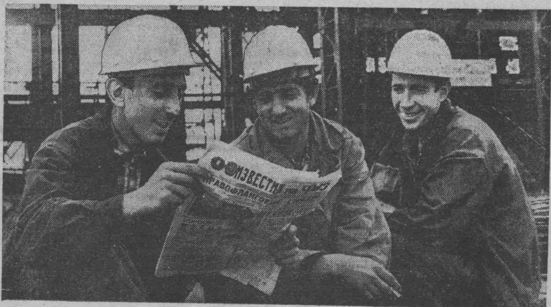
На строительстве кислородно-конверторного цеха Челябинского металлургического завода выездной редакцией «Известий» издается газета «Известия на ЧМЗ». Она пользуется большой популярностью среди рабочих.
