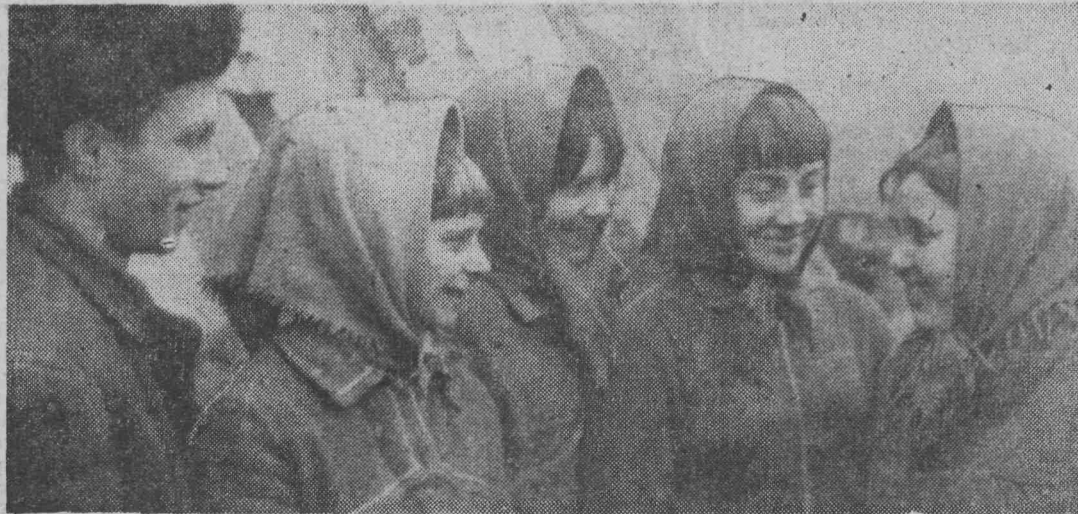
В Полысаевском шахто-строительном управлении славно работает бригада отделочников Виктора Карзанова. У них один дочерк тру-
