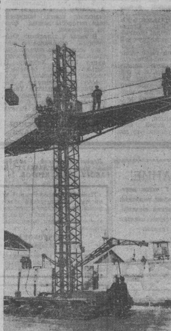
ТАДЖИКСКАЯ ССР. Коллектив душанбинского завода «Ремстройдормаш» создал и испытал самоходные электрические строительные леса. Они дадут десятки тысяч рублей экономии, так как опытные плотники, занятые на монтаже обычных лесов, теперь будут использованы на основных работах.
