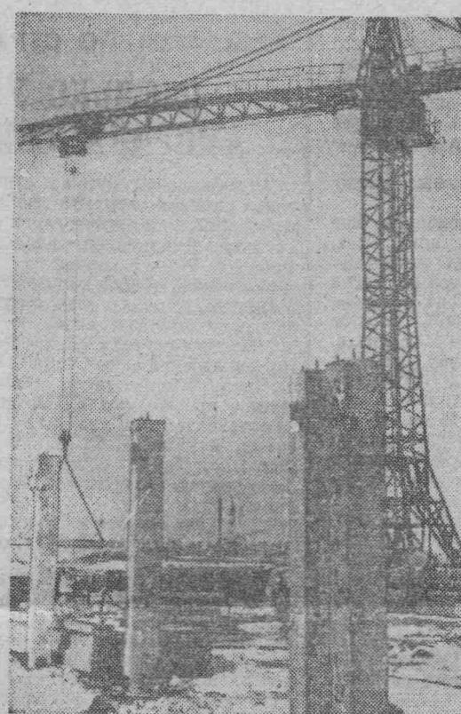
Этот снимок сделан на строительстве гараажа для автобусного предприятия всего несколько дней назад. Передовая бригада монтажников Попова в то время установила несколько железнобетонных колонн. А сейчас здесь их насчитывается уже более 30. Монтаж гараажа — стоянки для автобусов идет своим чередом. Фото Г. Дмитриева.
