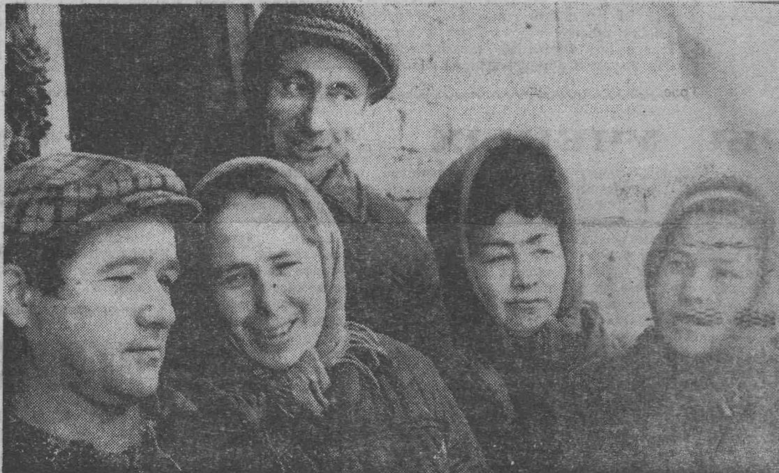
Более десяти лет работают в Полысаевском ЦСУ отделочники С. Батурин, В. Усанова, В. Карзанов (бригадир), И. Захарова и В. Вязникова, которых вы видите на этом снимке. Большой опыт помогает им быстро вести отделку помещений с хорошим качеством. Фото Г. Дмитриева.
