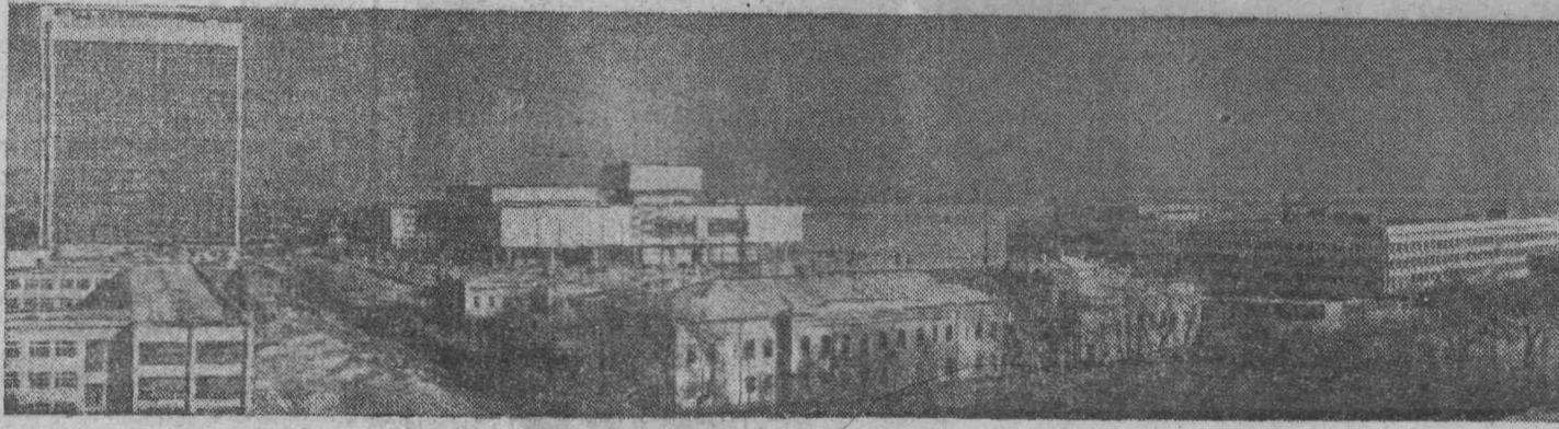
УЛЬЯНОВСК. Близится к завершению строительство Ленинской мемориальной зоны. Ударно трудится коллектив строителей, возводящий объекты величественного памятника вождю пролетариата.
