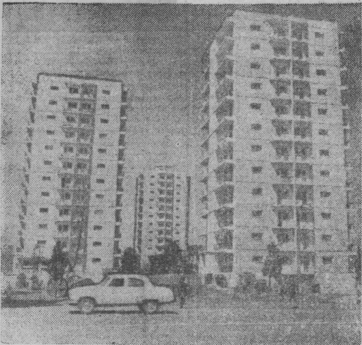
Столица Абхазии Батуми — один из красивейших городов Черноморского побережья. Здесь ведется большое жилищное, культурно-бытовое и промышленное строительство. НА СНИМКЕ: 12-этажные дома по улице Грибоедова. Фото Н. Анастасьева
