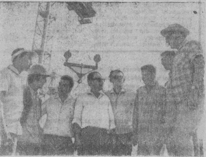
На снимках: сверху — на строительстве ГЭС; внизу — группа советских и сирийских рабочих. Фото В. Будана (Фотохроника ТАСС).
