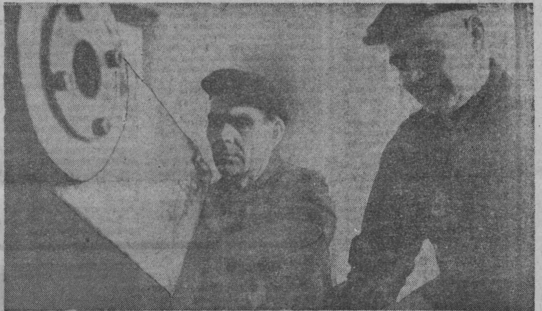
Бригада слесарей мехцеха шатты имени Кирова усовершенствовала монтажно-демонтажный станок. Приварили к лыжкам основания — траки. Теперь станок может передвигаться по глинистой почве. Отпала необходимость в маслостанции. Монтаж ком-
