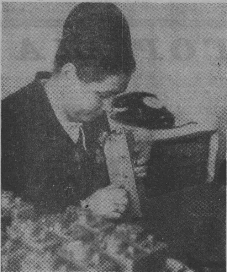
Электрослесарь Елизавета Павловна Волкова почти три десятилетия трудится на ремонте шахтовой электроаппаратуры. Сейчас высококвалифицированная работница качественно ремонтирует сложные приборы для определения метана и углекислого газа в рудничной атмосфере.
