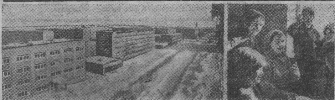
Коми АССР. По новому генеральному плану застраивается шахтерский город Инта. Это четвертый по величине город северной республики. Новый план застройки исходит из того, что население города в приполярной тундре в ближайшие годы вырастет до 75 тысяч человек. Возводятся торговые центры, спортивные и культурно-бытовые комплексы. Почти на сто тысяч квадратных метров увеличится в нынешней пятилетке жилой фонд Инты.
