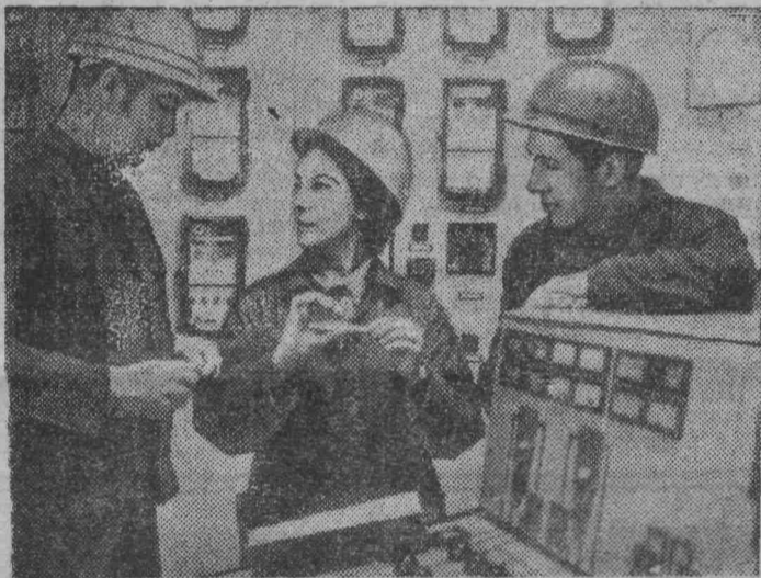
Электростанция в Турбахе (ГДР) введена в эксплуатацию в прошлом году. Четыре ее блока были созданы машиностроителями Советского Союза. Специалисты из СССР, помогавшие строить станцию, и по сей день не забывают своих немецких друзей.
