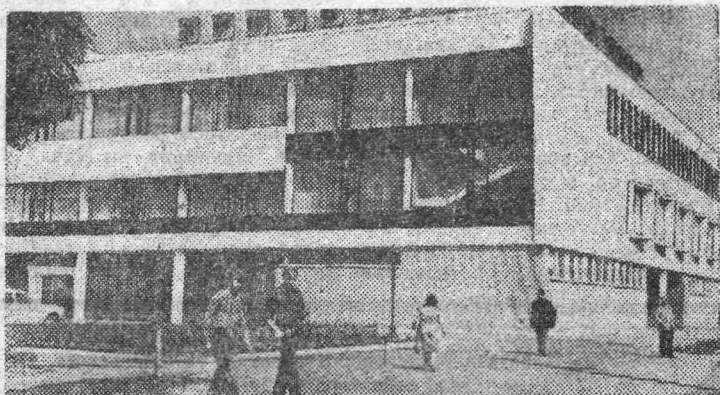
В Туле начал действовать новый Дом быта. В белоснежном здании из стекла и бетона разместились демонстрационные залы, швейные цеха, парикмахерские. Фото П. Маслова (Фотохроника ТАСС).
