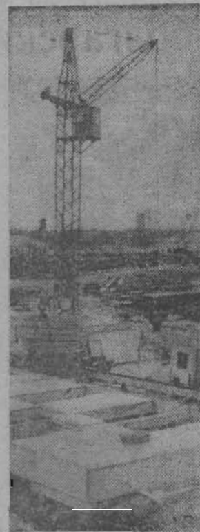
На снимках: Л. А. Макаров дает задание бригаде; монтажники начали сборку панелей нового 60-квартирного дома.
