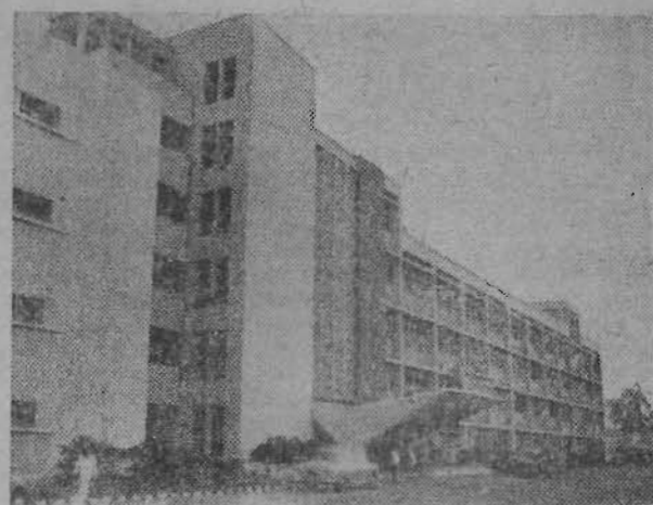
ИНДИЯ. Завод тяжелого электрооборудования в Хардваре, построенный при содействии Советского Союза, — главный в стране поставщик мощных паровых и гидравлических генераторов, турбин, электромоторов.
