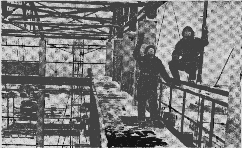
С каждым днем меняется облик новостройки котельной привокзального района. Работающая здесь бригада коммуниста Ю. С. Галадина возводит важный объект быстро и качественно.
