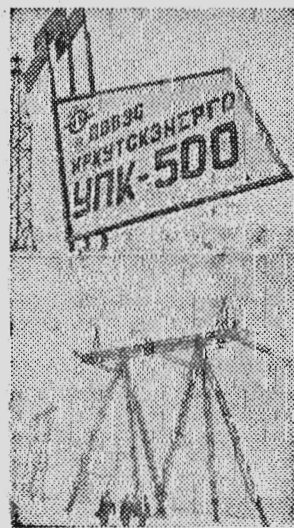
успехов в XII пятилетке. На снимке: опоры ЛЭП-500 на участке установки продольной компенсации. (Фотохроника ТАСС).
