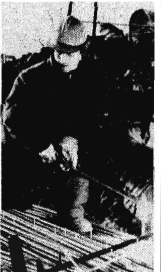
Армянская ССР. В республике продолжают работы по ликвидации последствий разрушительного землетрясения. Специалисты Минсезастроя СССР ведут строительство домов в Ленинакане. На снимке: на строительной площадке первого монолитного дома. (Фотохроника ТАСС)
