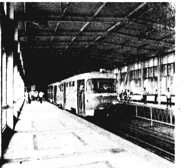
Высокую эффективность, надежность и безопасность показал в миллионном Волгограде скоростной трамвай. Его еще называют метротрамом, поскольку часть его тринадцатикилометровой трассы проходит под землей. В настоящее время строительство путей и подземной станции продолжается. Через несколько лет для значительной части горожан путь к месту работы и домой будет намного легче, чем ныне.
