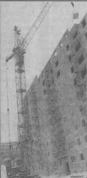
Бригада монтажников в ООО ПКФ «Инвестшахтострой», возглавляемая Геннадием Владимировичем Ширяевым, заканчивает монтаж десятиэтажного дома по проспекту Ленина. Темпы строительства, несмотря на морозы, коллектив поддерживает
