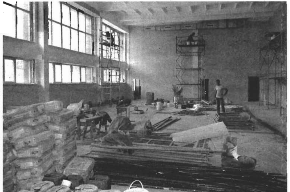
Большой объём работ выполнен в школе №8.
