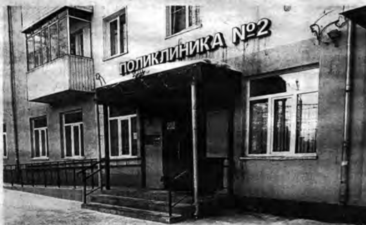
После ремонта, оборудования и оснащения, 2018 г.
