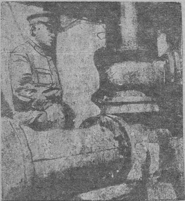
Инженер тов. ГРИНДЛЕР осматривает механизмы на участке подземной газификации
